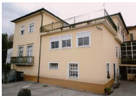
Traseiras de edifício do Patronato
