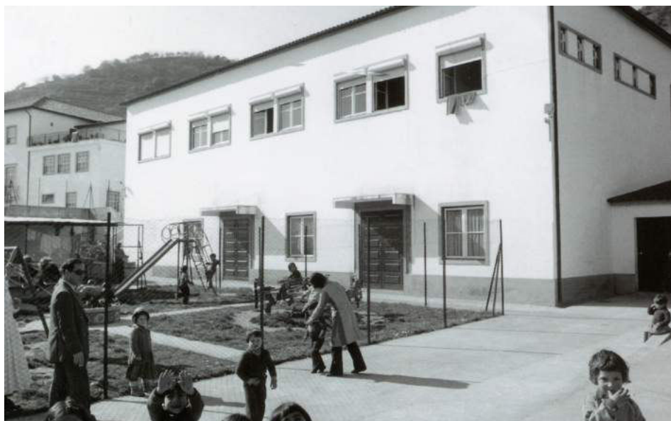
Traseiras do edifício da creche D. Antónia Adelaide Ferreira e parque
