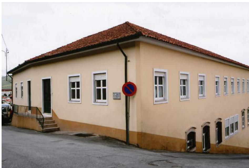
Parte frontal do edifício do Patronato
